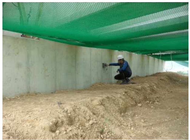
A1(영천방향) 벽체전면 철근배근탐사 전경
