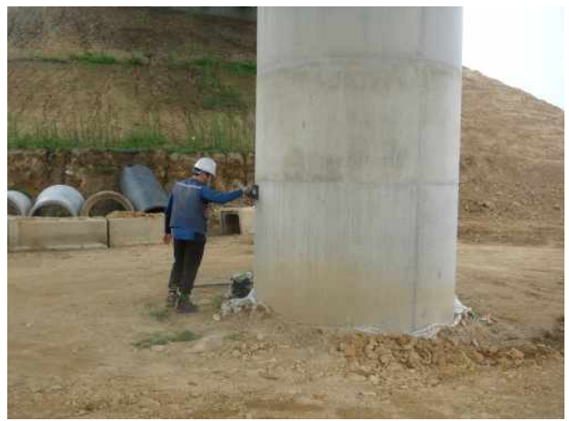
P1(상주방향) 기둥부 철근배근탐사 전경
