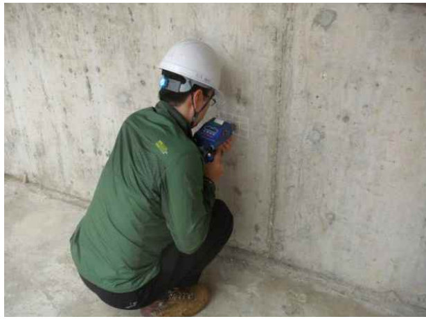
A1(영천방향) 벽체배면 반발경도시험 전경
