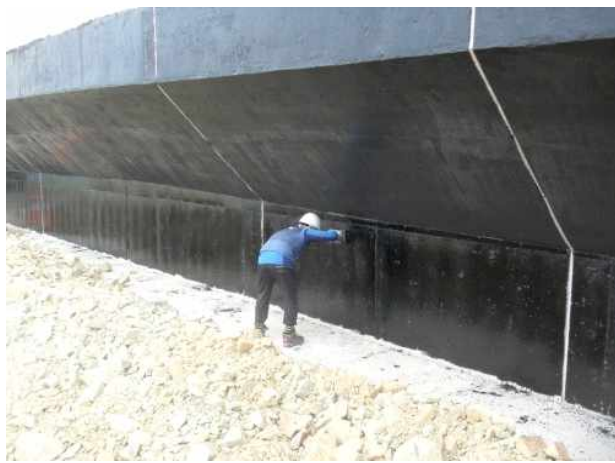
A1(영천방향) 벽체배면 철근배근탐사 전경
