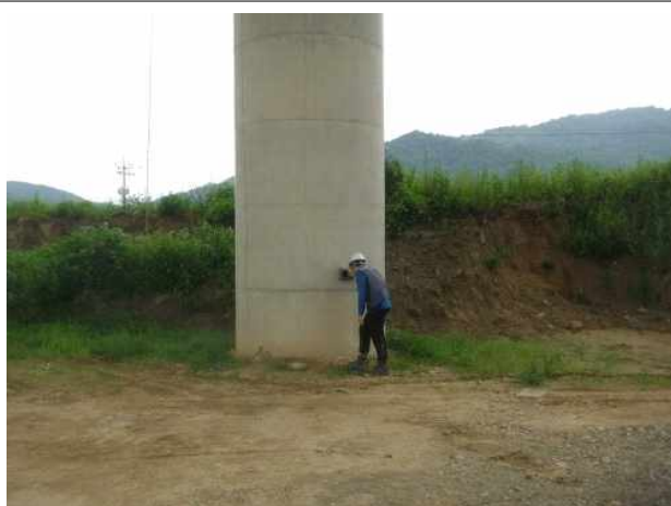
P3(영천방향) 기둥부 철근배근탐사 전경
