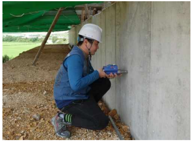
A2(상주방향) 벽체전면 반발경도시험 전경
