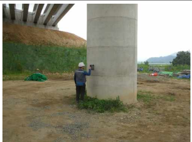
P5(영천방향) 기둥부 철근배근탐사 전경
