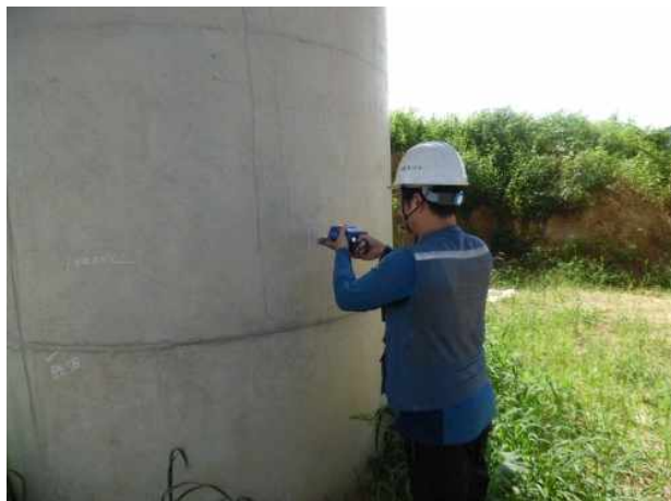
P3(영천방향) 기둥부 반발경도시험 전경
