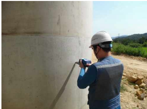
P1(영천방향) 기둥부 반발경도시험 전경
